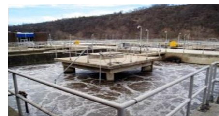
การบำบัดน้ำเสีย
